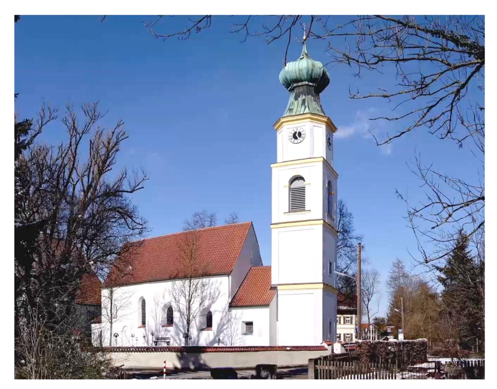
Dorfkirche Sankt Georg Obermenzing Fundamente 9. Jhrt
