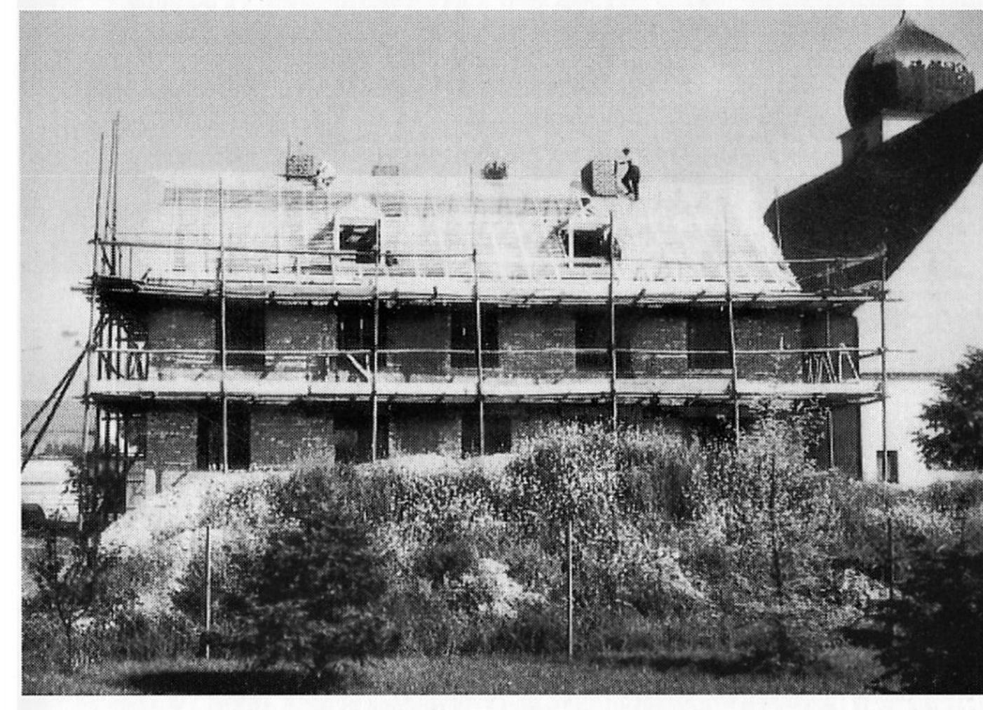
Abb. 7: Rohbau des Pfarrhauses 1956.
