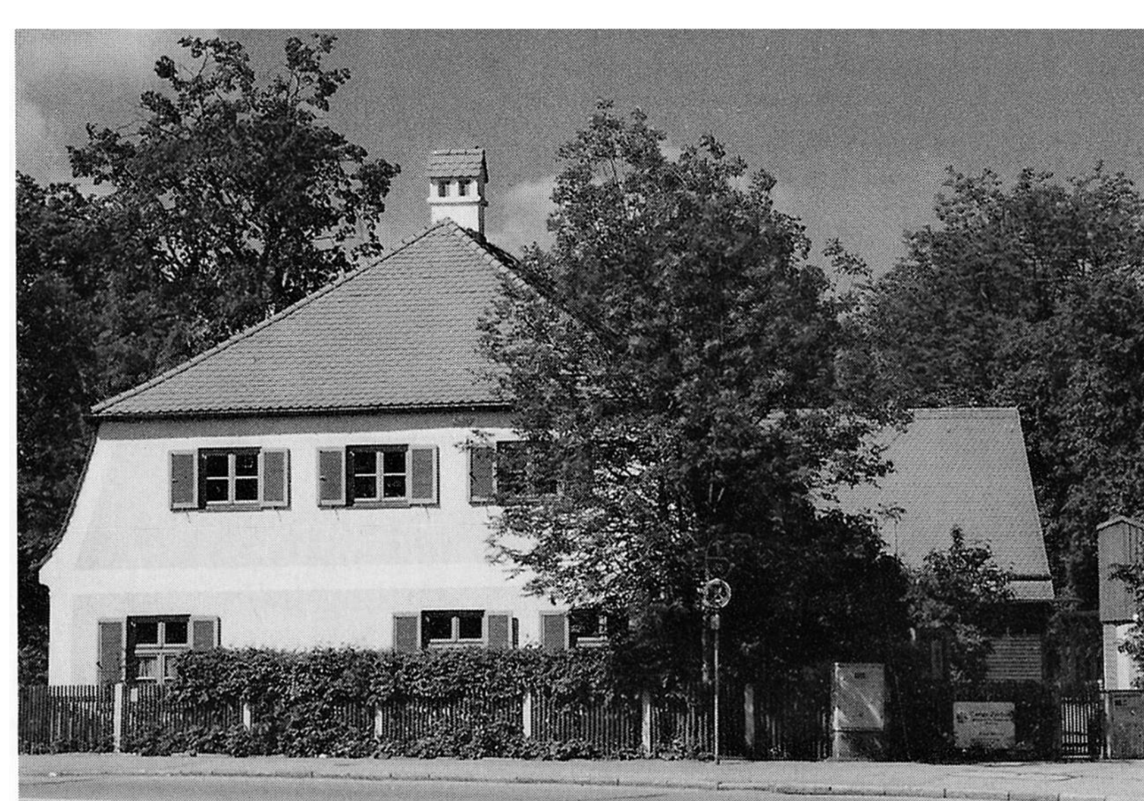
Abb. 15: Ehemaliges Benefiziantenhaus. Caritasstelle seit 1972.
