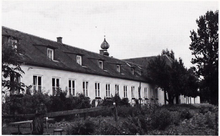
Plünderungen des Gebäudes
