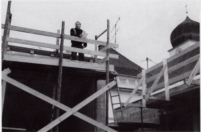
Zimmermeister Maier beim Richtspruch (20.6.1996)
