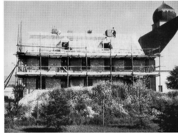
Der Rohbau des Pfarrhauses
