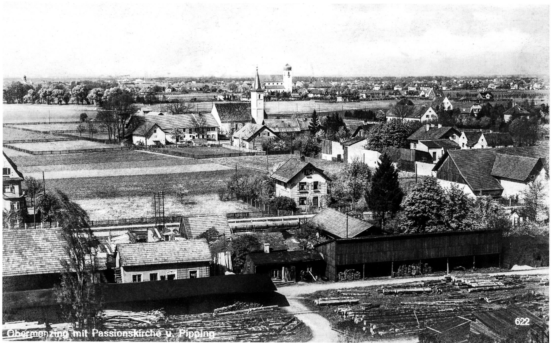
Blick über die Holzstapel des Sägewerks Stadler auf St. Wolfgang in Pipping, im Hintergrund Leiden Christi. Aufnahme von 1935.
