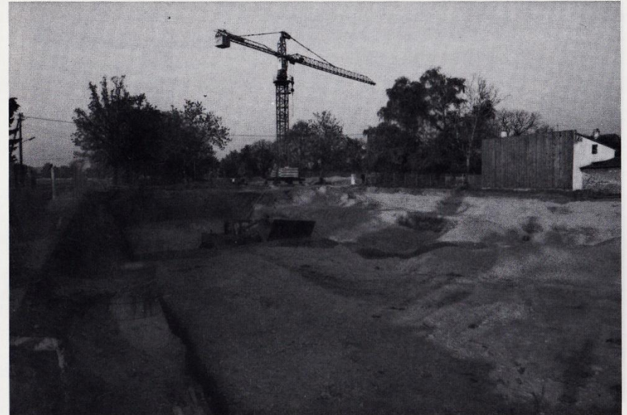
Die Betonsteinwahr wird aufgetragen
