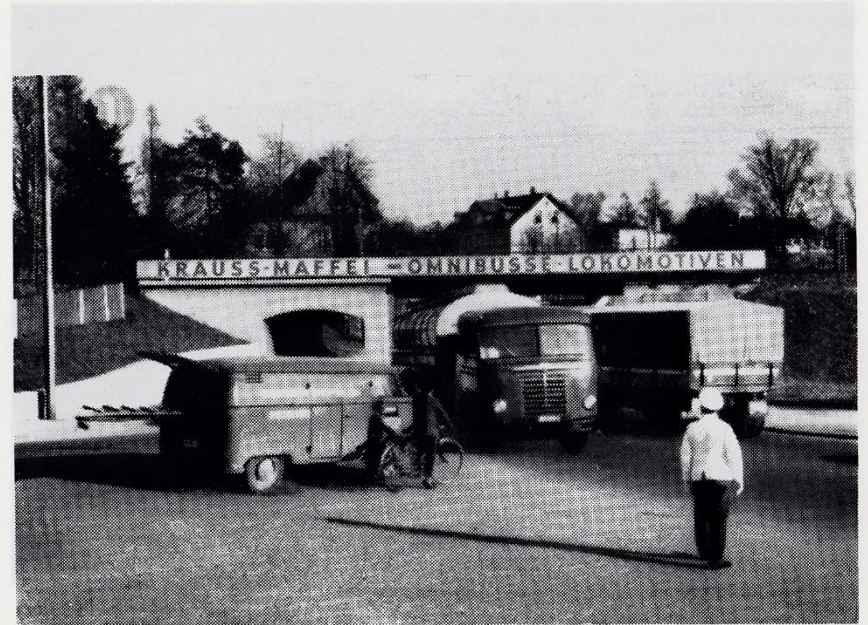
Alte Unterführung Menzinger Straße
